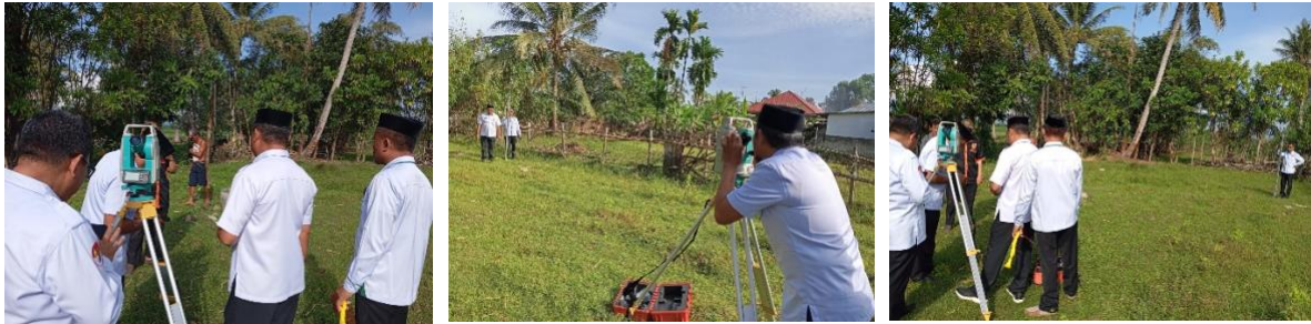
Gambar 7. Penandaan arah kiblat di lokasi pembangunan masjid dengan menggunakan benang dan tanda patok permanen
