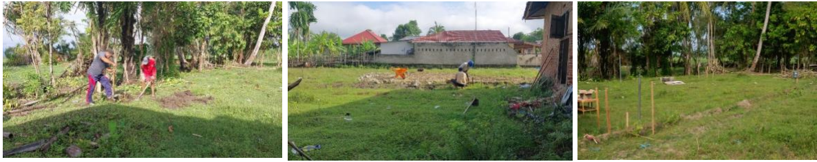
Gambar 14. Penandaan titik pondasi dengan patok kayu berdasarkan garis as dan hasil pengukuran lapangan
