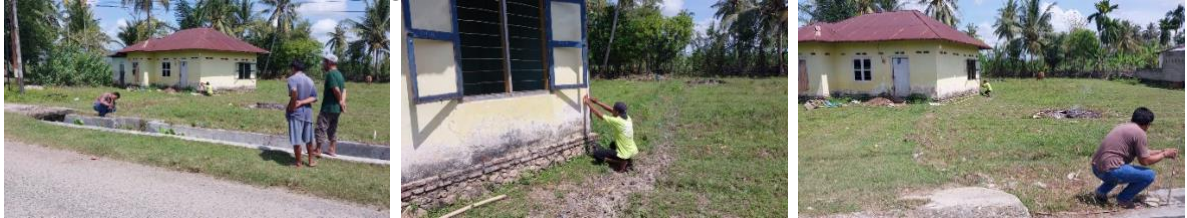
Gambar 9. Pemasangan patok titik pondasi berdasarkan koordinat garis as dan pengecekan elevasi lapangan
