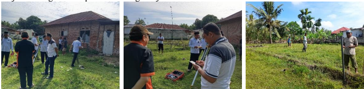
Gambar 8: Penarikan garis as arah kiblat dan as tegak lurus oleh tim pengabdi di titik pusat pembangunan masjid
